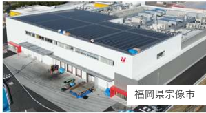
稼働を開始した米飯新工場
