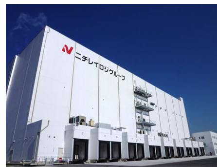
東扇島物流センターの主要設備
