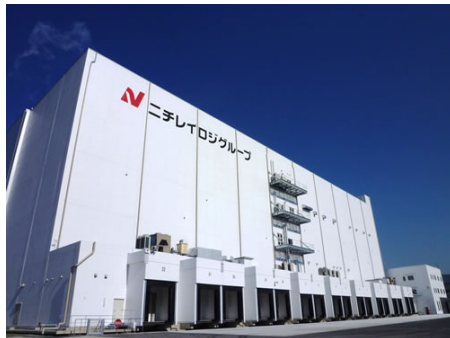
東扇島物流センターの主要設備
