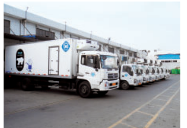
施設面積2,300㎡(F級:600㎡、C級:1,700㎡)。主に外食店向けの、冷凍・冷蔵商品を保管しています
