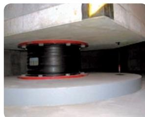
直径1mの免震装置を88ヶ所に備え、施設全体が免震構造になっています
