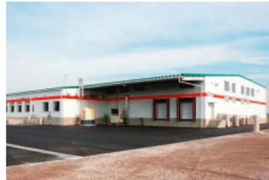
建物は、建築面積3,536㎡の鉄骨構造。内部は、選果エリアと加工エリアがあり、それぞれ衛生レベルによってゾーンを分けています
