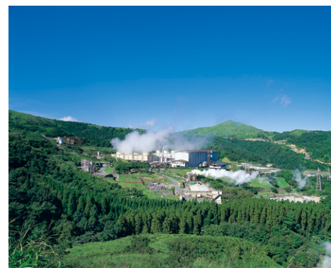
地熱発電所 （九電みらいエナジー 八丁原発電所）
