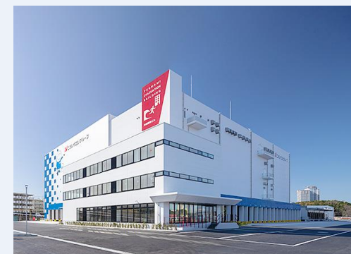
名古屋みなとDC 2023年3月に太陽光発電パネル設置予定
