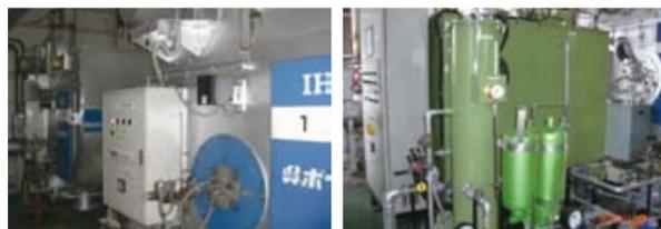
船橋工場の廃食用油と燃料の混合装置(左)、中冷 廃食油ボイラー(右)
