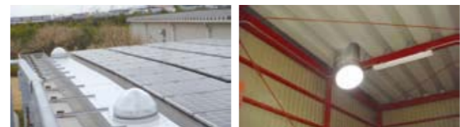
屋根の上のドーム(左)と室内(右)
