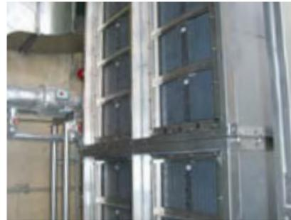
気化熱により空気を冷やす装置
