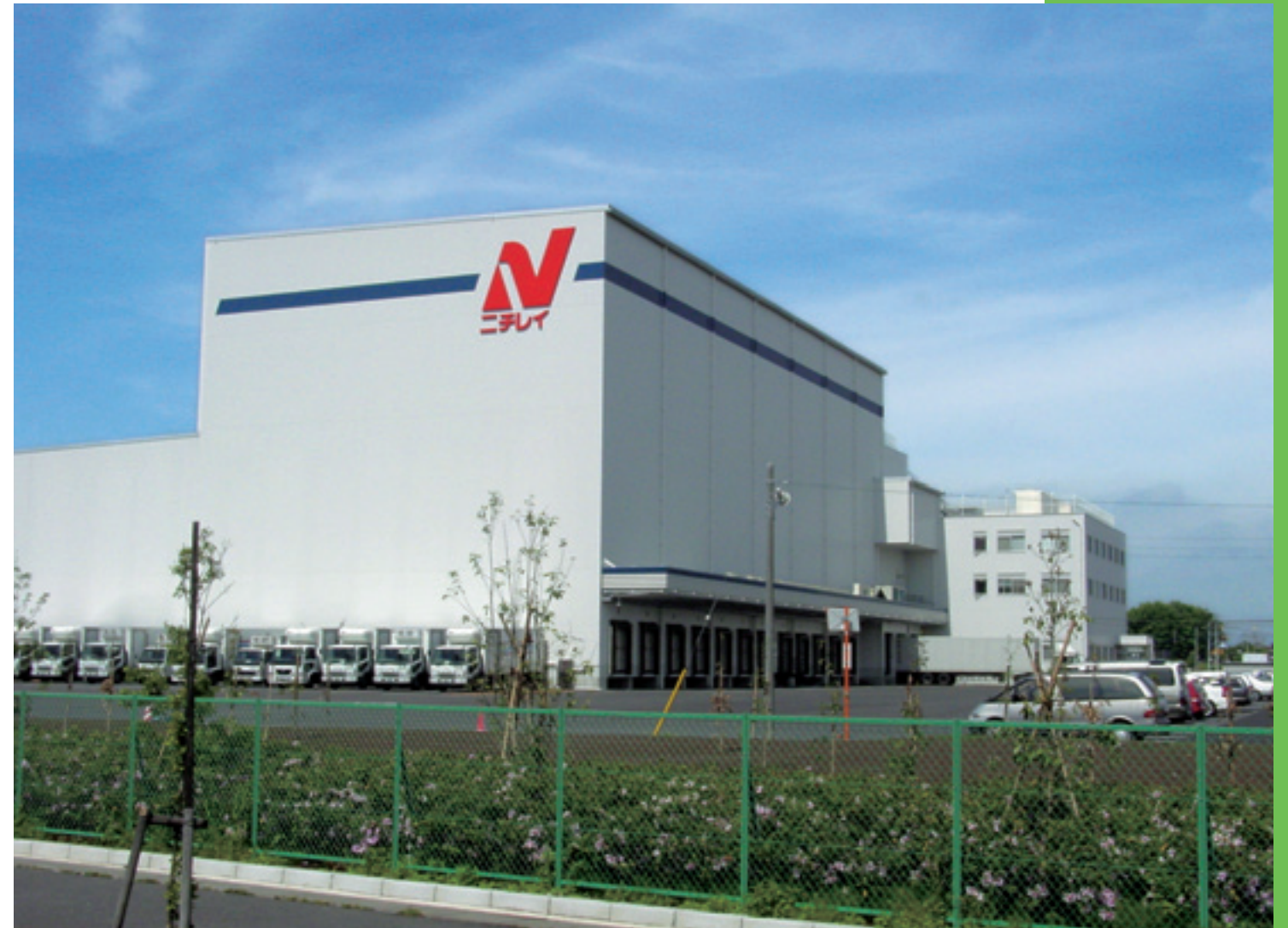
環境配慮を徹底した 杉戸物流センターを新設
