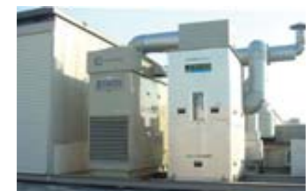
マイクロガスタービンによるコージェネレーションシステム
