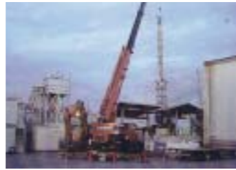
焼却炉の撤去作業風景
