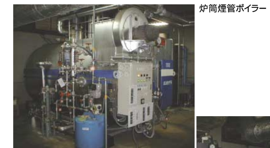
炉筒煙管ボイラー
