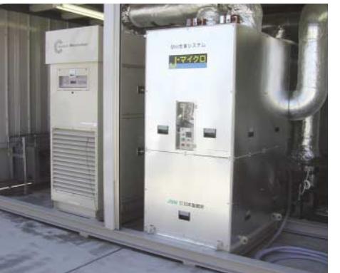
技術開発センターに設置された試験装置 左：マイクロガスタービン、右：MH冷凍システム
