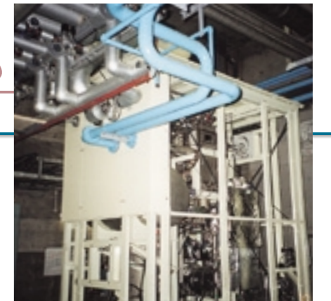
2001年3月に(株)ニチレイ大阪堺頭LSCに導入されたアンモニア吸収式冷凍機
