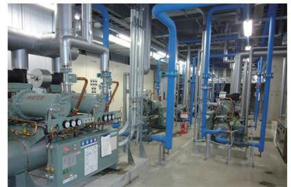
2018年9月からは日立製作所と共同で、船橋物流センターにおいて、先端IoT技術を活用し、冷凍設備の故障予兆診断と、設備運転・メンテナンスの効率化に向けた共同実証を行っています。エネルギー消費を可視化し、運用改善の分析をすることで、冷蔵設備の高効率運転の支援を可能とし、CO<sub>2</sub>を削減していきます。
