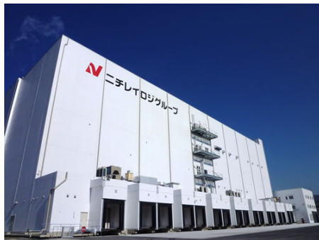
東扇島物流センターの主要設備
